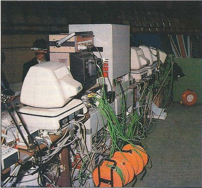
Sehr viele Kabel sind zu verlegen. Auf dem Foto sehen Sie den kleinen Ausschnitt der Anlage auf dem Richterturm.
